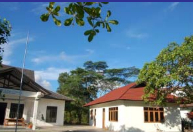
Sekolah Bina Cita Utama, Kalimantan Centre
